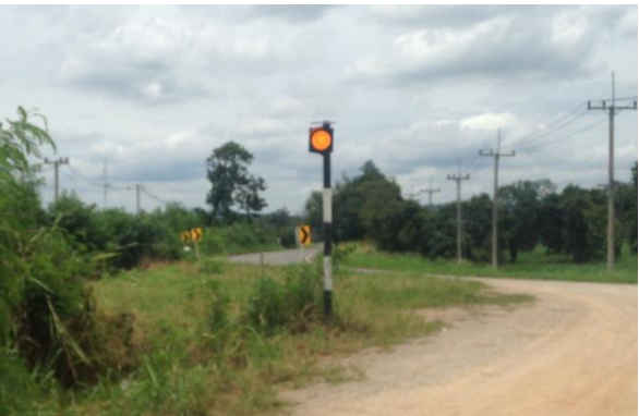
หนองข้างตาย ติดตั้งสัญญาณไฟ
