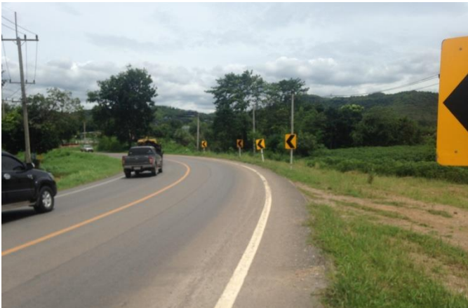
หนองข้างตาย ติดตั้งป้ายให้สัญญาณข้างทาง
